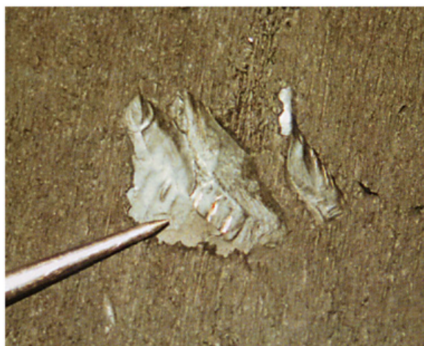
Acima, este dano requer pouco tempo de escavação na área danificada.
